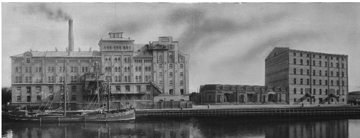
Valskvarnen från norr 1904. Till vänster den ursprungliga kvarnbyggnaden, idag rivna. Till höger blanderiet (uppfört 1902) vars fasad finns bevarad och integrerad i den nuvarande anläggningen.
